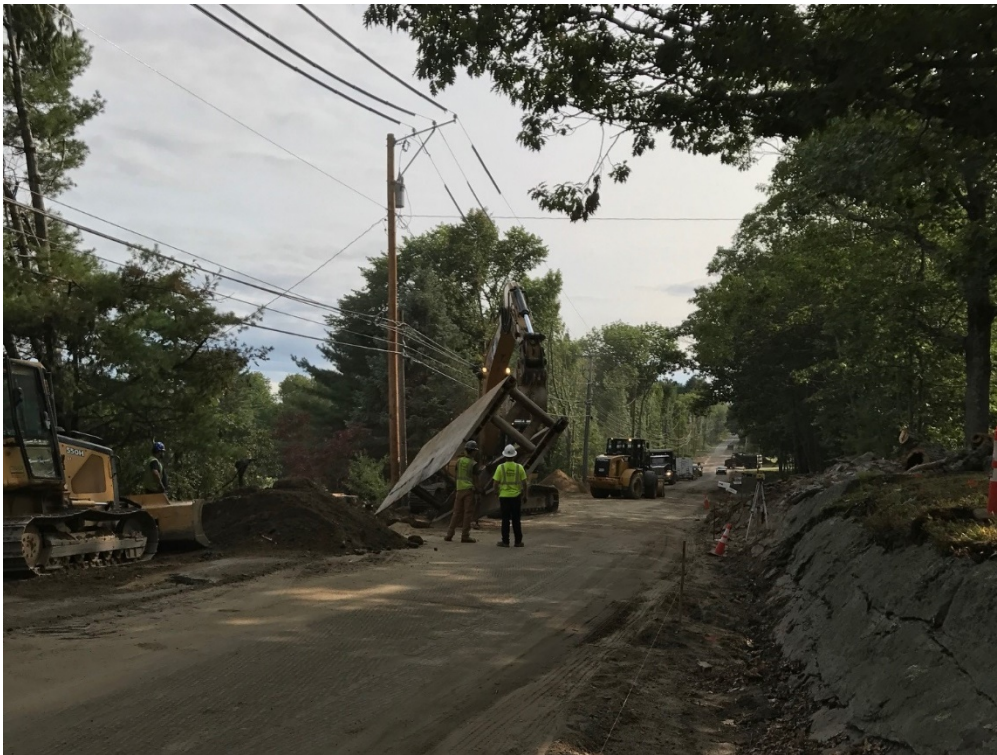
Remove Trench Box, STA 34+56.
